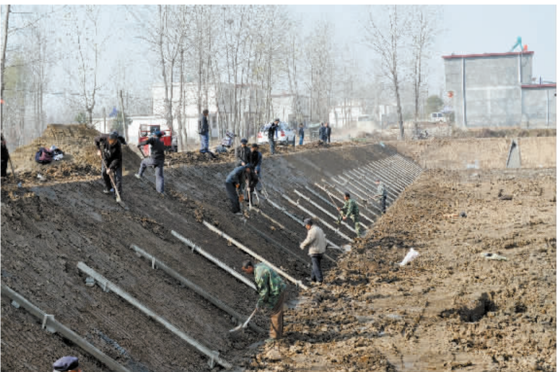
连日来,平桥区抓住兴修水利的大好时机,加快推进小型农田水利重点县项目建设,全面兴起冬春农田水利基本建设热潮。图为施工人员在该区长台关乡整修改造塘坝。
