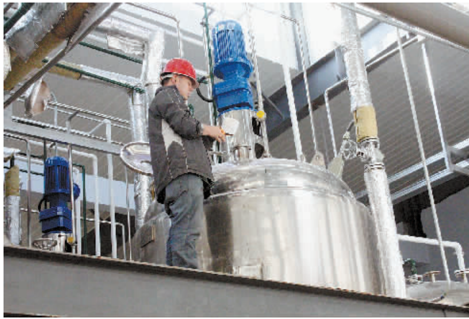
信阳工业城聆锐健康产业园项目在信阳工业城和市直各职能部门的推动下,园区的基础设施建设已基本完成,部分设备已经安装,即将投入生产。图为日前技术人员正在对新安装设备进行检测。本报记者 曹新俊 摄
