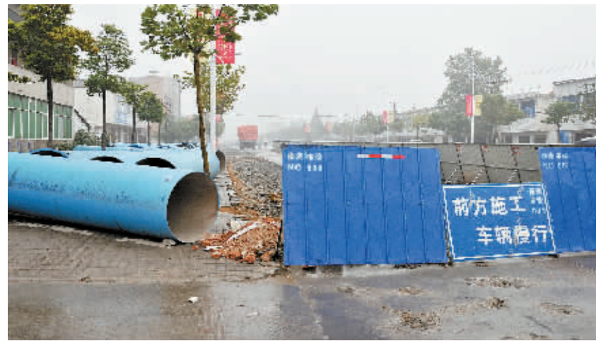
我市污水处理二期中水回用管道工程施工现场
