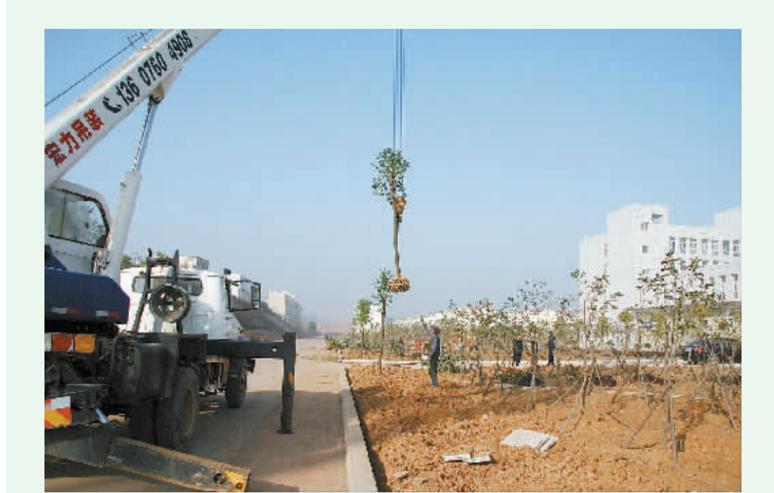
当前正是创建全国绿化模范城市植树建园的好时节,羊山新区前进办事处抓紧眼下晴好天气,将三桥社区门前废弃苗圃地改造成游园。该游园占地3500多平方米,植满各色苗木花草,添置了园艺小品和健身器材,将成为附近居民休闲娱乐的好去处。图为施工人员进行带冠的大棵香樟树吊运提前挖好的树穴。
