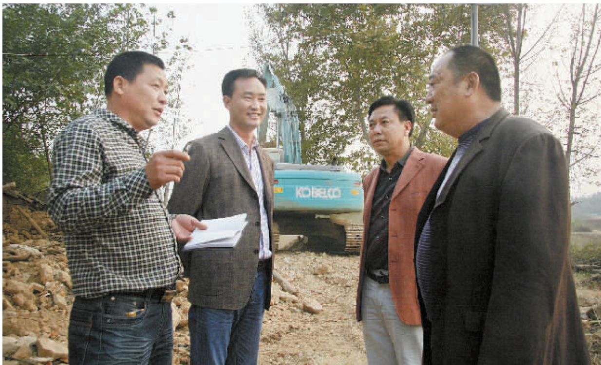
为促进农村经济发展和解决村民行路难的问题,平桥区五里办事处七桥村多方筹措资金,开工建设一条与郝堂村连接,1.5公里长,5米宽的太平山山西环水泥路。图为七桥村村委会主任杨明强(左一)在修路的工地上向村干部强调:倒排工期,保质保量,一定要修出让群众满意的致富路。 李建设 摄
