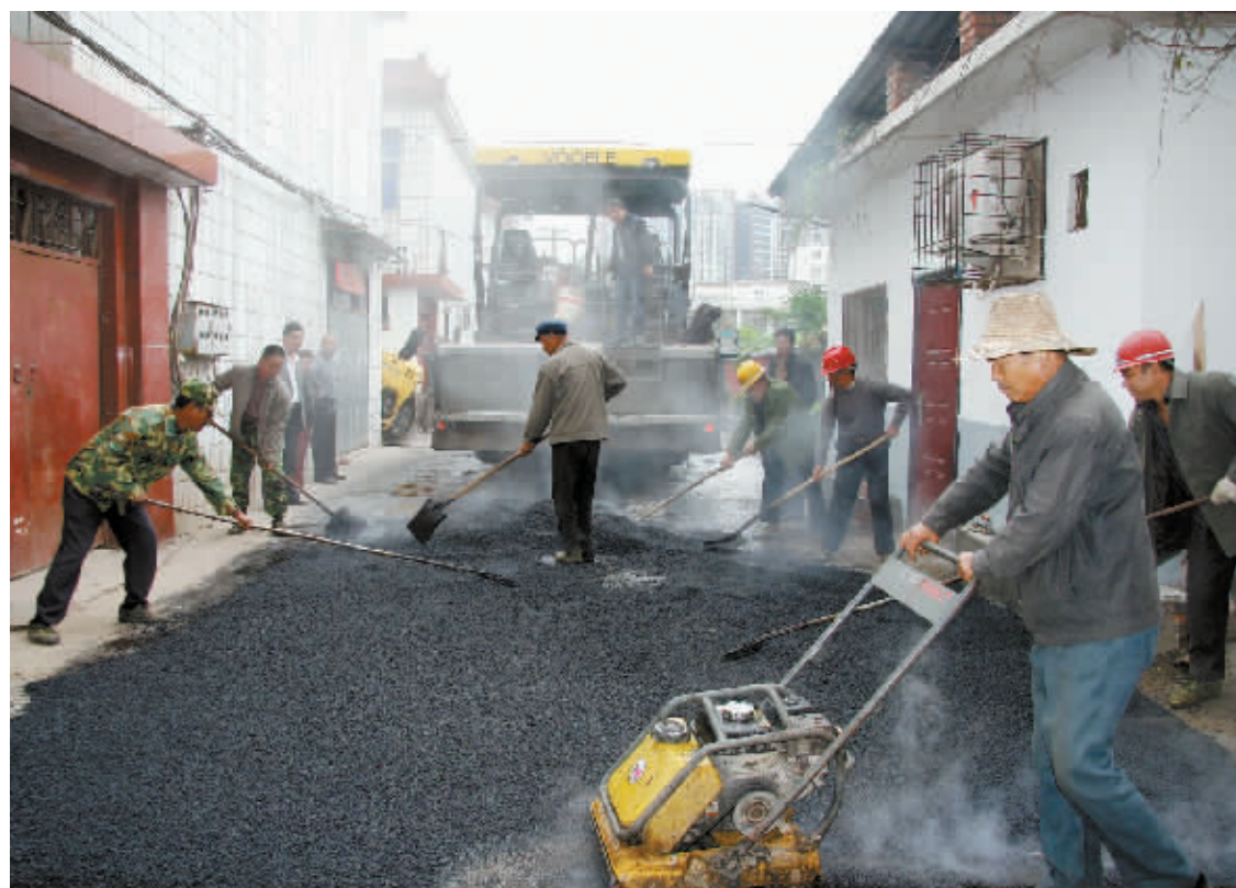
居民房地基下的老旧排水道淤堵严重,位于市区南湖路至浙河北岸红星社区九组胡同一度成汛期泄洪河道。浙河区五星办事处继今年8月从胡同中间重做排水系统后,日前又对该胡同进行硬化、绿化、亮化、美化,受到当地居民交口称赞。图为施工人员在胡同内铺设沥青路面。
