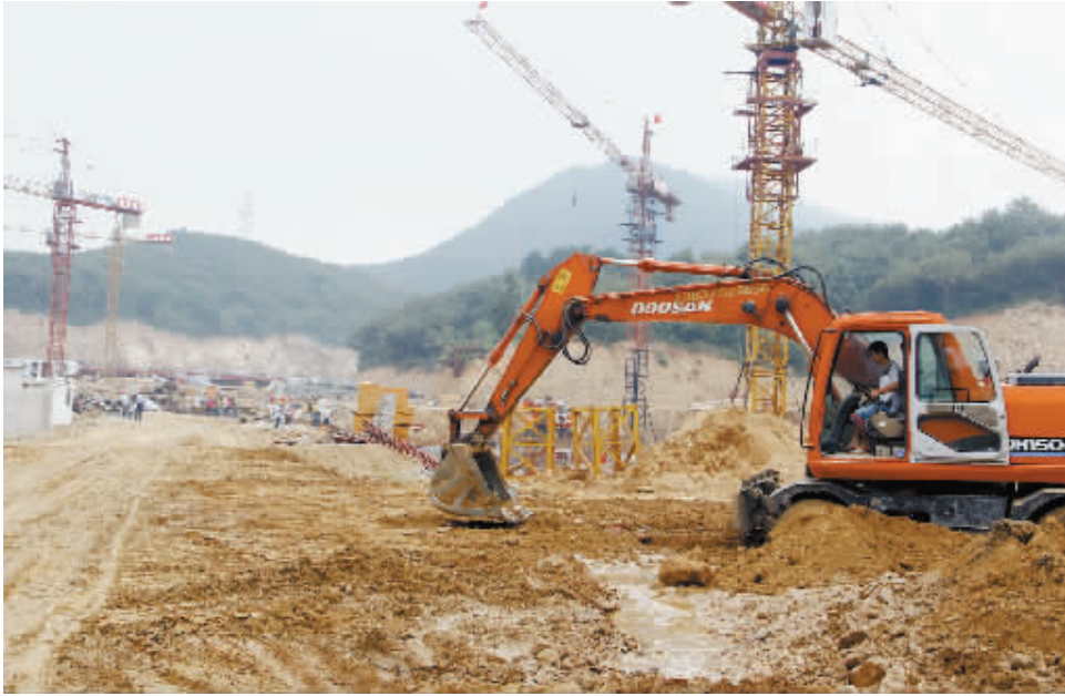
新县大别山干部学院自去年10月筹建以来,各项基础设施建设全面展开,目前工程进度顺利。图为施工现场。本报记者 卢小龙 摄
