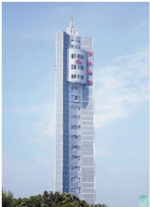
河南阳光实业集团立塔车间高168米,是国内最高的工业生产线,集约化程度高,比传统工艺节约土地近20亩。 史晶 摄
