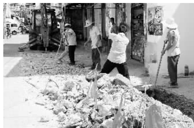
不久前的一场强降雨,令市中心城区红星社区九组内南湖路至浉河北岸胡同积水瞬间涨为“城市内河”。为从根本上解决汛期积水问题,辖区五星办事处决定并用淤堵在居民房屋地基下的老旧下水道,改从胡同中间重做排水系统。图为8月9日上午,工人顶着烈日开挖破路修建排水系统。 本报记者 方慧玲 摄
