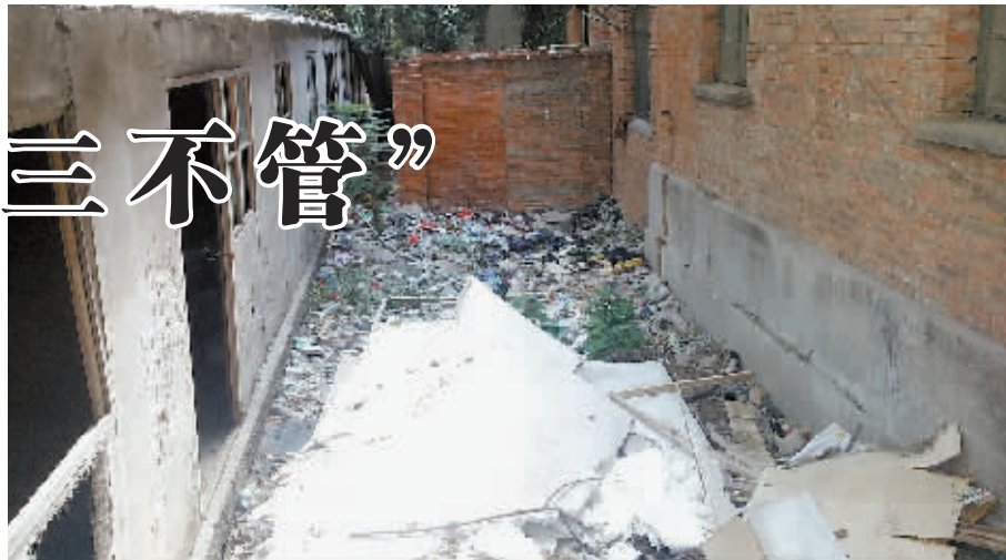
满是垃圾的工棚在高温天气散发出浓烈的恶臭。
