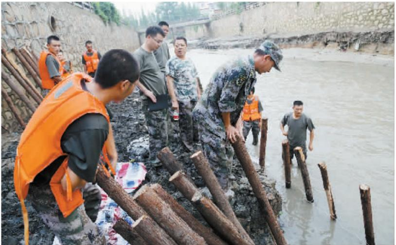
前几日,在大暴雨中,大唐(信阳)华豫发电有限公司三条过河水管网中的一条被大水冲断。驻信一支工兵部队接到求救电话后,迅速赶赴事发地进行救援。官兵们看到,河水虽已经退去,但河堤坍塌严重,急需进行加固处理。由于机械无法展开作业,官兵们只能采取人工作业的方法,把木桩一根一根打入河道中,然后手抬肩扛,把沙袋放置到护堤内。经过10余个小时的紧张施工排除了险情,确保了信阳地区和华东电网的供电安全。
