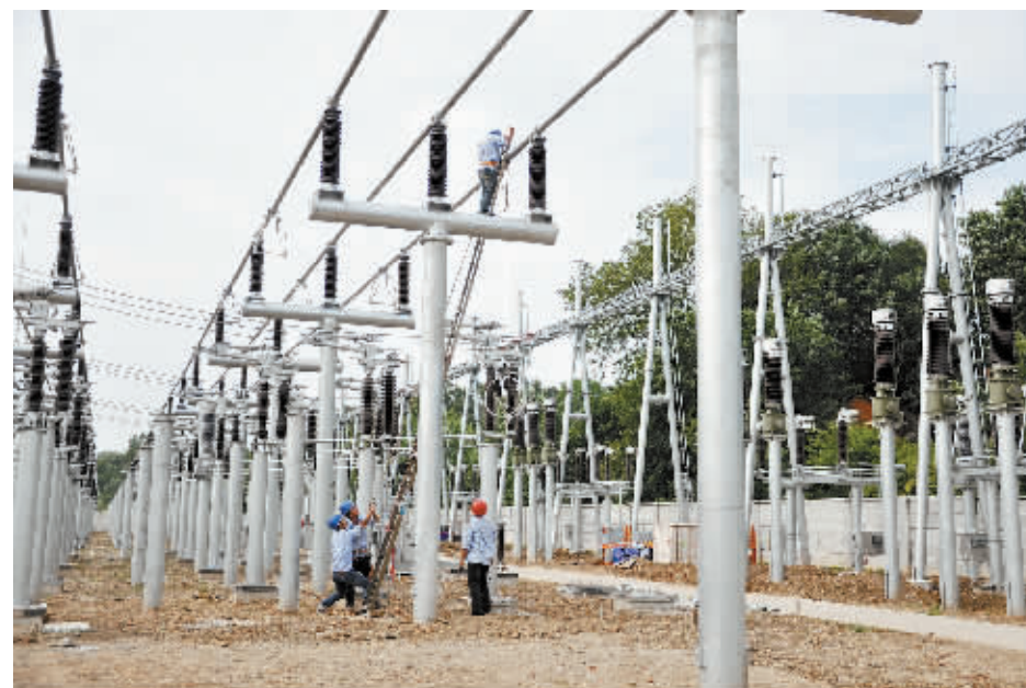
昨日,在220千伏叶桥变电站施工现场,信阳供电公司施工人员冒着高温正在紧张有序地工作。据了解,该变电站建成后,将对满足我市南部地区日益增长的用电负荷,完善电网布局,减轻市内供电负荷压力,支撑南部地区经济发展具有重要意义。
