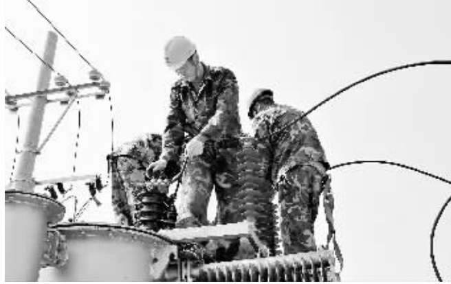
近日,固始县电业局完成了祖师35千伏变电站2号主变的增容改造工作,同时将有主变更换到赵岗35KV简易站,通过“以新换旧,以大换小”的方式,缓解用电高峰期间的负荷压力,满足用电需求。
