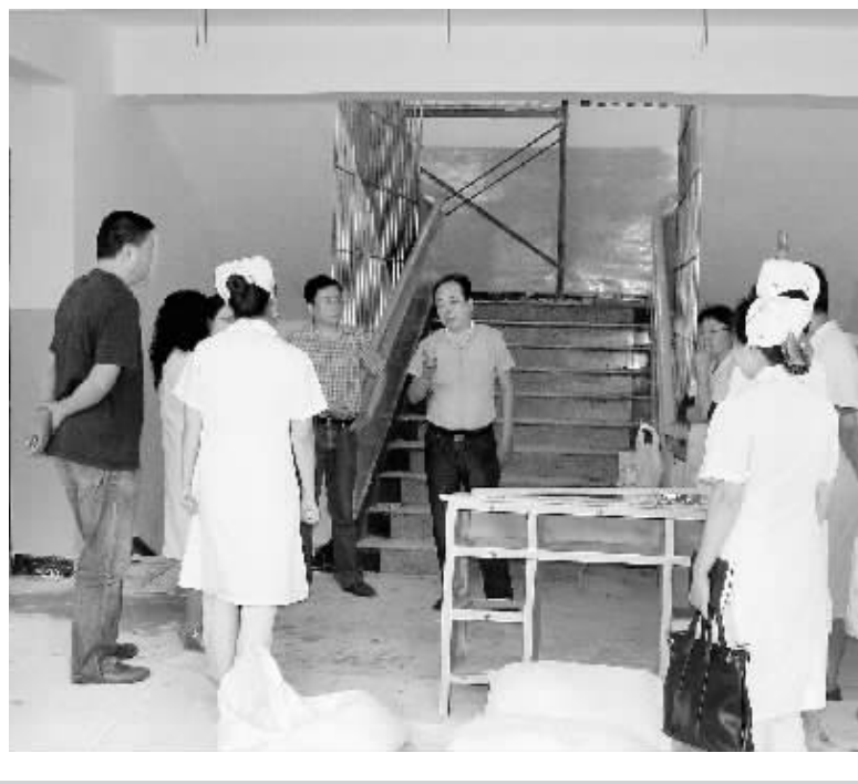
为认真落实市长乔新江在信阳职业技术学院附属医院病房建设项目工程现场办公会上的讲话精神,加快项目建设进程,该院领导高度重视,合理规划建设方案,积极做好搬迁前的各项工作。图为院长王健、项目主管院长范玉峰等与该院相关科室负责人在施工现场。邓冬梅 朱晓红 摄
