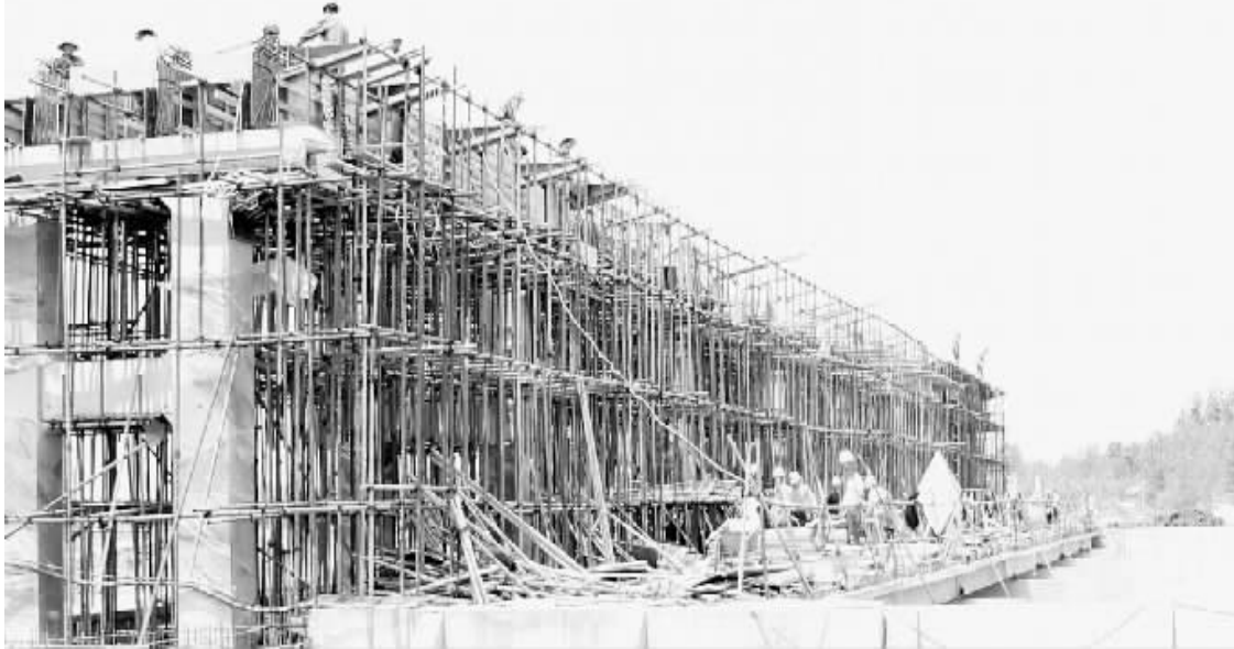
为确保在建工程安全度汛,我市突出抓好病险水库除险加固工程建设,切实加快建设速度。截至目前,全市有220座大中小水库已完成了除险加固工程建设任务,有2座中型和142座小型水库正在实施除险加固。图为日前罗山县龙山乡小龙山水库除险加固工程正在加紧施工。
