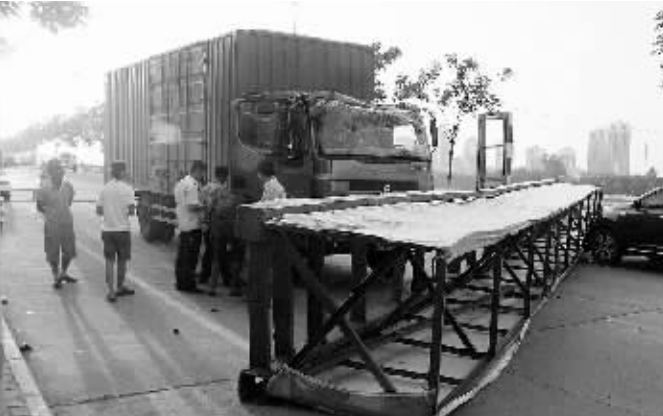
6月15日傍晚,在浉河区五星办事处八一村琵琶大桥西侧,一辆车牌号为豫SB1699的超高箱式大货车由西向东行驶,不慎将琵琶大桥的钢骨龙门架撞断。不仅该车撞坏了汽车驾驶室,同时,也将一辆此时正由东向西行驶的东风悦达起亚牌小汽车前引擎撞坏。所幸的是这两辆车的司机均安然无恙,但一时造成了浉河南岸交通的中断。李建设 摄
