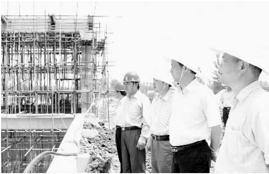
为把各项防汛措施落到实处,近日,市防汛抗旱指挥部组织检查组深入各县区对防汛准备工作、水库除险加固工程建设等进行检查。图为检查组正在检查罗山县防汛在建工程。本报记者 殷英 摄
