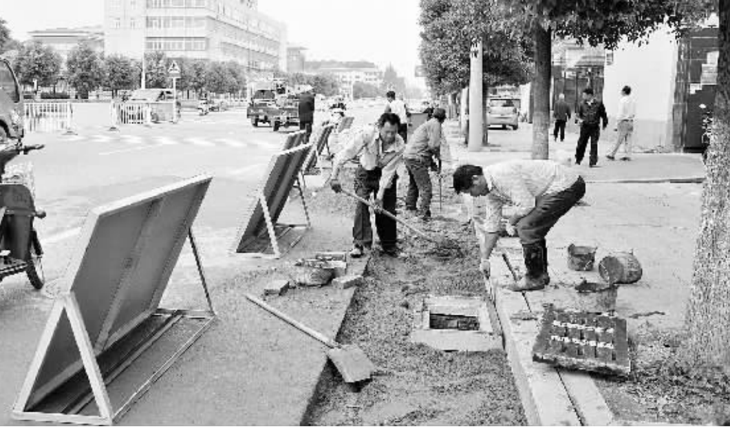
进入夏季,雨水增多,城区道路排水量也将增加。近日,我市市政部门组织施工人员对中心城区雨天易积水的路段进行维修、改造,铺设新的排水管道,全力提升城市管网的排水能力,确保城区路面排水顺畅。图为航空路一施工现场。
