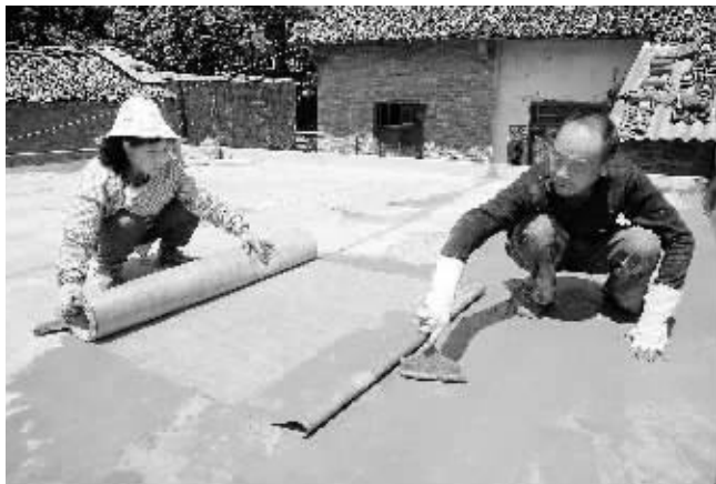
新县浒湾乡党委、乡政府十分关心贫困户的生活。该乡游田村81岁的贫困老人董幼青享受低保待遇,危房改造项目让她住进了新房子。日前,村里为董幼青老人的房屋进行防水处理,让她住得更安心。图为施工情景。
