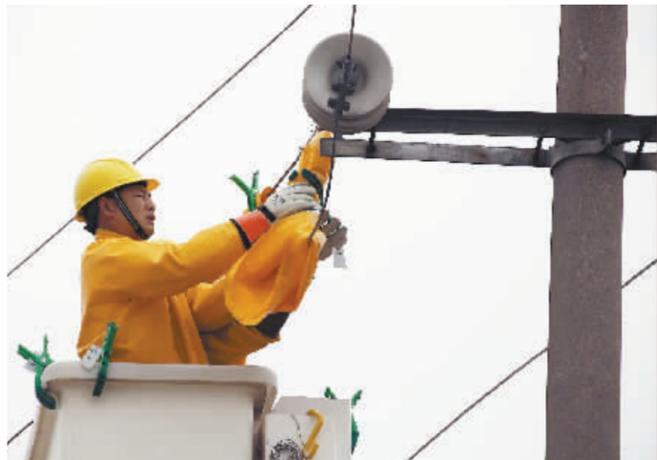
为减少停电给用户带来的不便,潢川县电业局增加带电作业次数,今年1月至4月,共开展带电作业37次,减少停电时间近150小时。图为近日该局带电作业班在10千伏潢1线实施带电拆除分支引流线的情景。杨君摄
