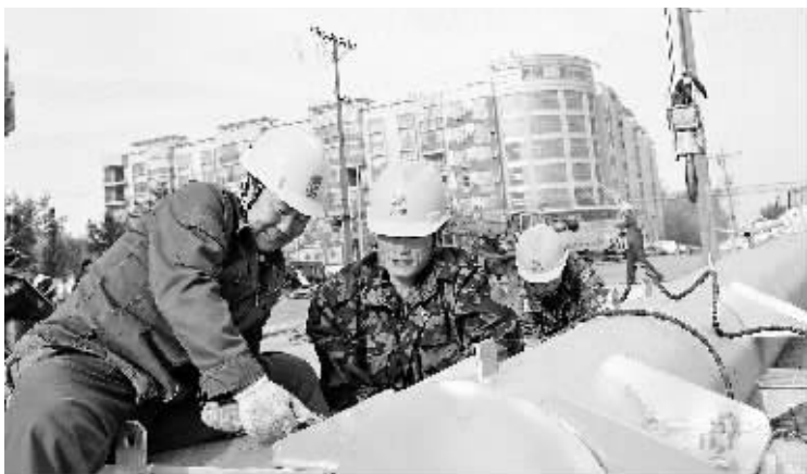
随着城区用电负荷的增长,城区部分线路和配电变压器已严重过负荷,为此,4月18日,固始县电业局对城大道路部分10千伏线路和台区进行升级改造,以满足城区用电负荷需求。
