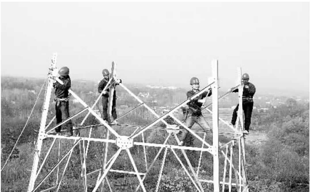
为在雨季来临前如期完成工程施工任务,连日来,在信阳鸡公山山区,信阳供电公司抢抓目前难得的好天气,科学施工,全力推进110千伏线路改造工程...
