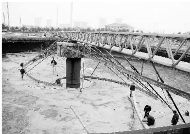
近年来,市污水处理公司污水处理量、污染物削减量均大幅增加,日均处理污水9.7万吨,发挥了城市节能减排的主力军作用。图为公司员工正在维修污水处理重要设施二沉池。本报记者 方慧玲 摄
