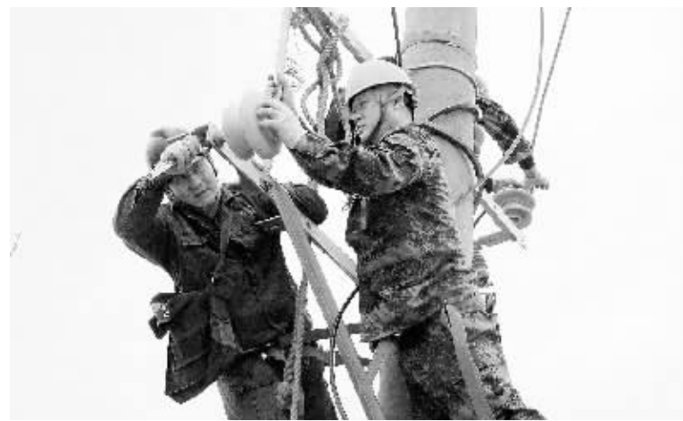
近日,固始县电业局施工人员在汪棚乡联山村新立电杆16基、架设线路220米、新增100千伏安变压器一台,为村民春耕春灌提供坚强的电力保障,受到该村村民的高度称赞。李松 摄
