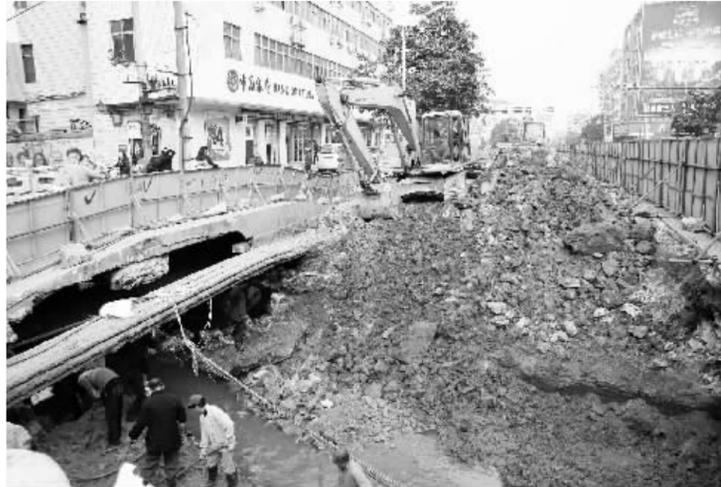
为解决新中河上游暴雨期间内涝问题,市政府决定对阻水严重的该河东方红大桥实施扩宽改造。改造后,该桥由原跨径5米扩宽至12米,净高3米,将大大增强行洪能力。该工程3月中旬开工,计划工期60天。图为昨日上午,市政工人正在桥下施工。
