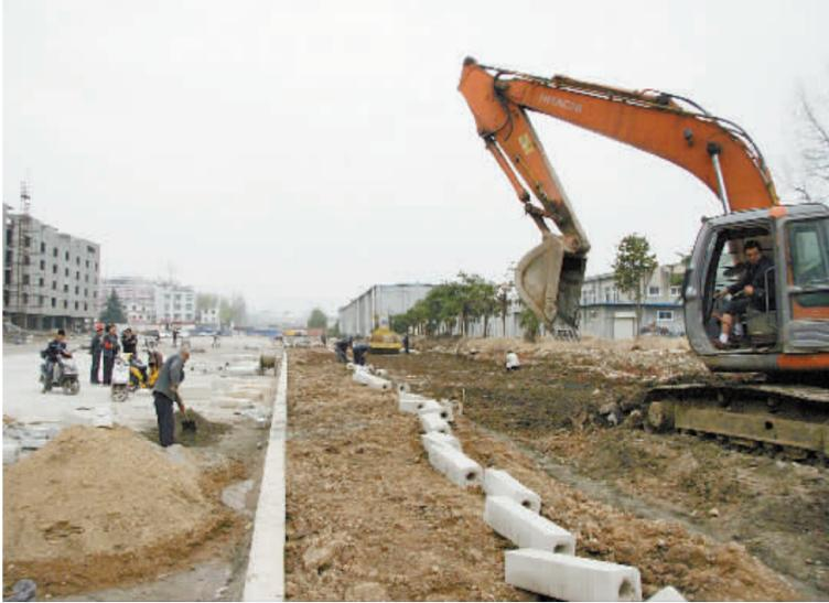
市区春晓路打通工程是2012年市政府“十件实事”之一。目前该路南标段中城大道至滨河北路的雨污、自来水、燃气、弱电等管网入地和快车道的水泥稳定结构层已完成,正在进行人行道基础垫层铺设。据了解,该路段将于今年茶文化节前完工。图为施工现场。 本报记者 方慧玲 摄
