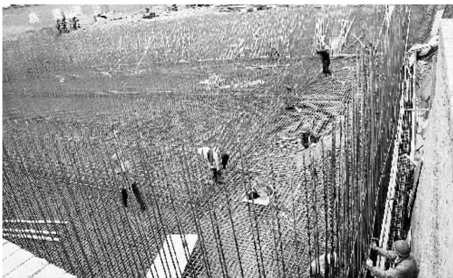
中水,也称再生水,是城市污水、废水经净化处理后达到国家标准,可用于工业、城市景观和百姓生活诸多方面的非饮用水。随着工业和城市快速发展对水资源需求的不断增加,我市也越来越重视对再生水资源的利用,并开始建设日产8万吨的中水回用厂。图为昨日上午,施工人员在紧张地修建中水回用厂清水池。 本报记者 方慧玲 摄
