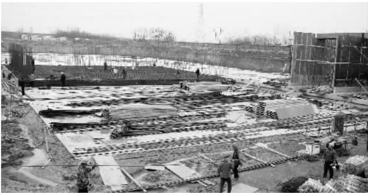
市政府2013年十件实事之一的市污水处理二期工程包括10万吨/日的污水处理厂、8万吨/日的中水回用厂、配套的88公里排污管网。目前项目进展顺利,已完成工程建设总量的40%,完成投资1.5亿元,预计2014年11月完工。图为正在建设中的污水处理厂氧化沟。本报记者 方慧玲 摄
