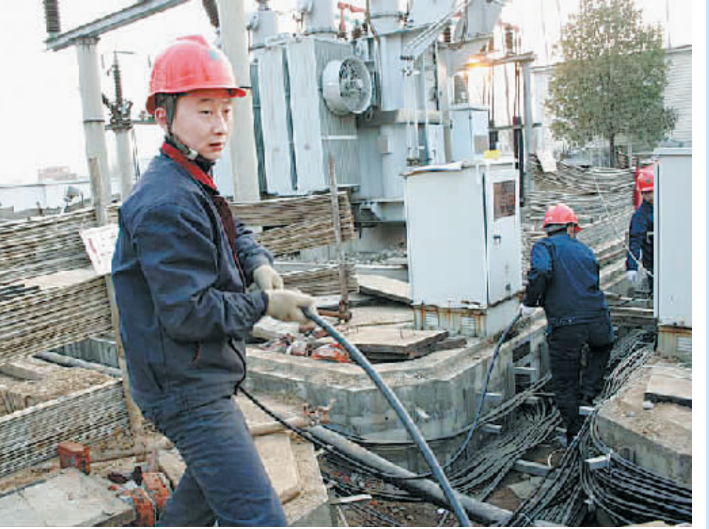
为了确保春节期间群众用电安全稳定,连日来,光山县电业局加大紫水站扩建工程建设力度,努力克服时间紧、任务重、天气严寒等不利因素,在确保安全和质量的前提下,加班加点抢抓施工进度,目前已基本完成工作任务。图为施工人員正在紧张施工。
