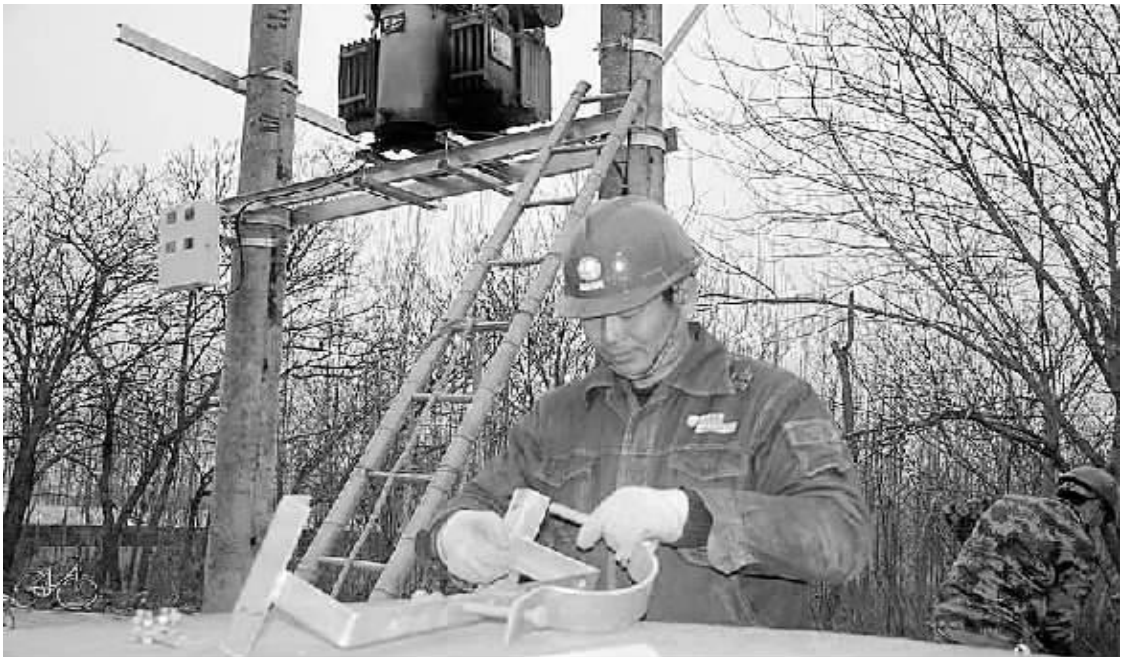
日前,固始县电业局施工人员不顾严寒,为东大店社区新立电杆8基,新增200千伏变压器一台,保障该村260余户村民的冬季可靠用电,受到村民们的高度称赞。
