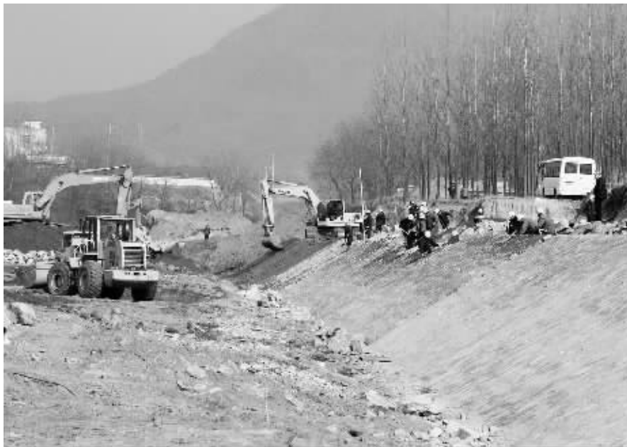
入冬以来,新县围绕重点项目,积极开展农田水利基本建设,夯实农业基础,确保增产增收。日前,记者在新县小潢河蔡庄段治理工程现场采访时看到挖掘机正轰鸣作业,数十名群众齐心协力整修河堤,一派热火朝天的施工场面。
