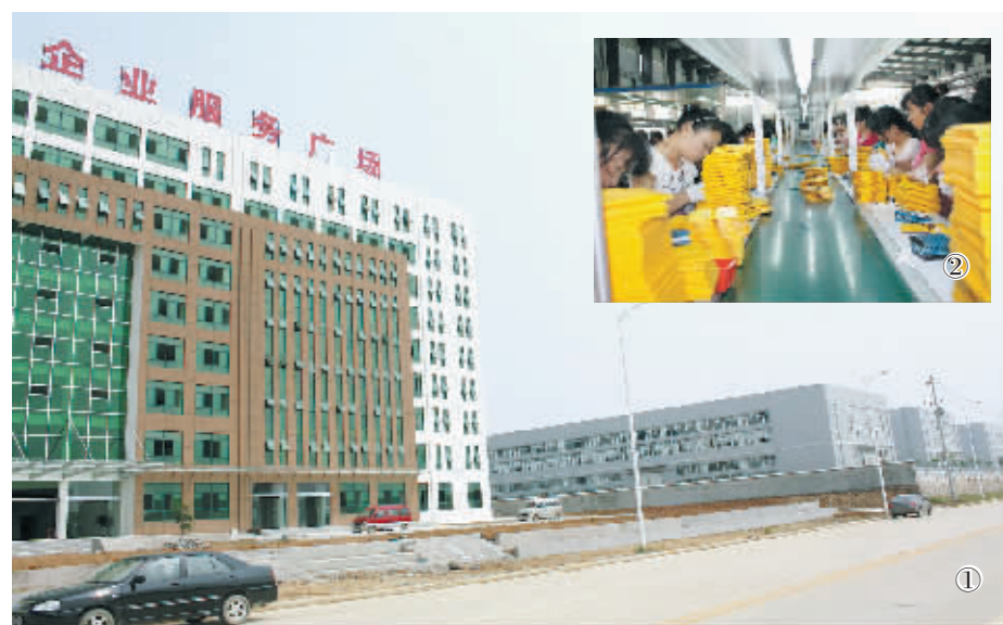
图①为信阳工业城即将建成使用的企业服务广场。图②为信阳工业城电子产业园生产车间。
