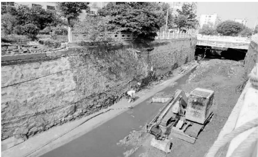
今年入汛以来, 连续的几次降雨导致我市污水管道水流量大, 雨污分流施工河道积水多, 影响了工程进度。为在8月底前全面完成新中河雨污分流工程, 施工人员在雨后利用水泵加紧排水, 确保工程进度。图为市中心医院附近河道施工现场, 工人正在铺管排水。
