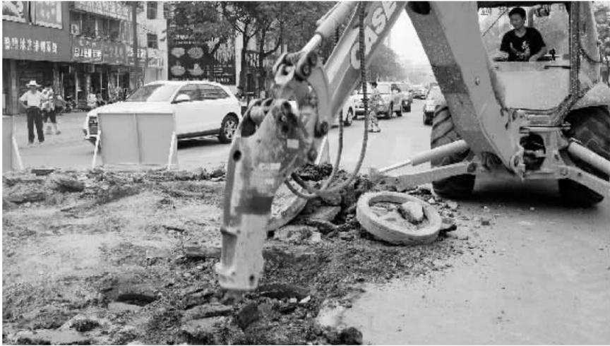
市城市管理局综合执法局采取增设雨水井、增加排水管网、扩大排水管径、增加截污沟等措施,改造中心城区道路积水点,解决雨季积水问题。图为积水点改造施工现场。 程琳 摄
