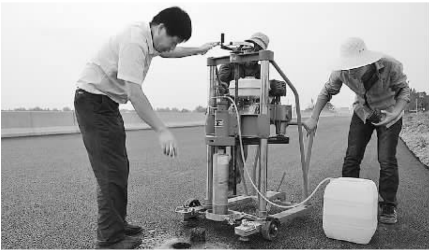
河南万达路桥集团有限公司承建S216线沪陕高速公路商城站北出口至商城县城段改建工程后,战高温斗酷暑,争创优质工程。图为该公司质检人员正在认真抽检铺设路面的质量。曹峻 摄
