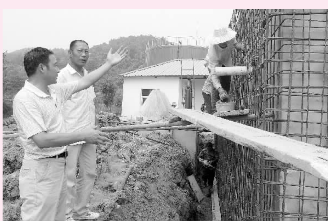
今年以来,泌阳县五星办事处在推进中原经济区建设中,加快科学发展步伐,大力发展生态种植业、养殖业,注重节能环保,五星观青山养殖基地率先建成标准化大型沼气池,通过发酵、沉淀、过滤、循环,使养殖污水变成清澈洁净的生产用水,不仅有效治理了污染,而且还使周边群众用上了新能源。图为施工现场。 刘文强 胡燕摄
