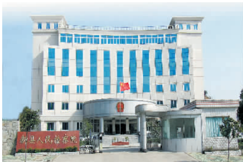
图为新县检察院办公区。
