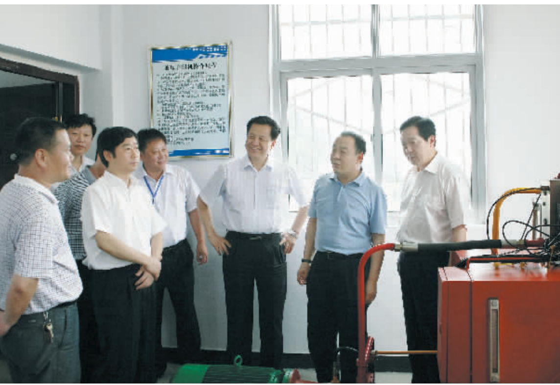
图为毛超峰(右二)在石山口水库干渠首闸应急发电房里检查防汛工作。 本报记者 方慧玲 摄
