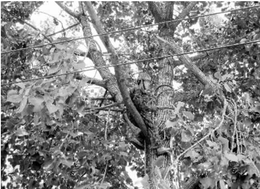
为全面清理线路通道内的树木及障碍物,减少线路故障,保证市区正常供电,连日来,信阳供电公司配电网服务中心的员工不顾炎炎烈日,爬上安全梯,积极排查安全隐患。因为该中心的员工正在清理市区肖湾一处大树树枝,确保线路供电安全。 刘国启 摄
