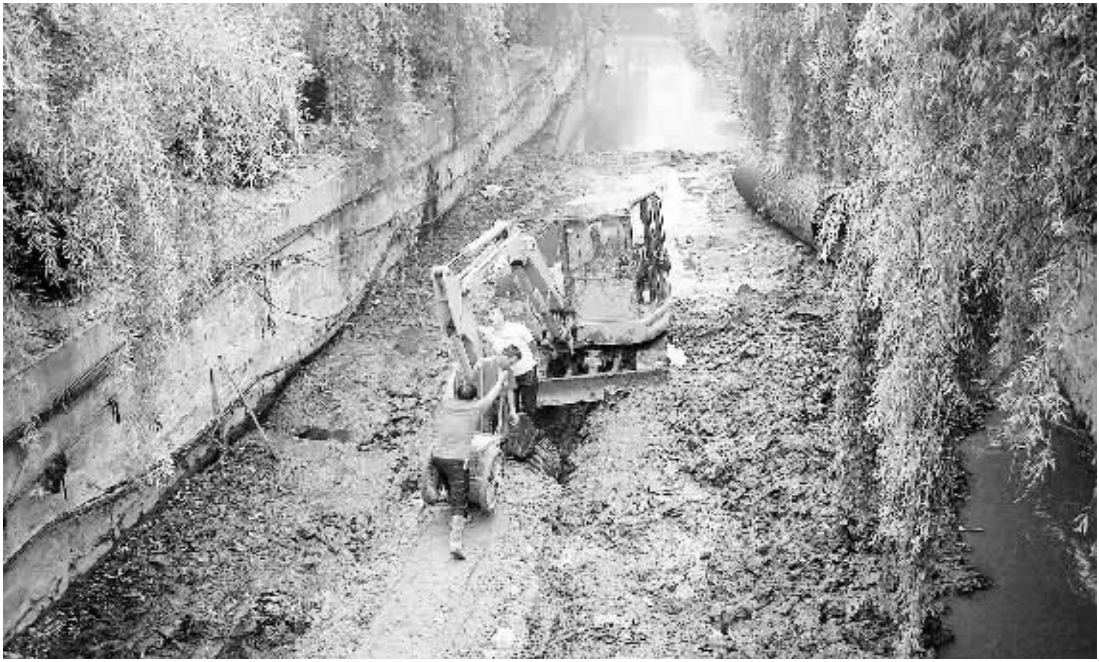
近日,浙河区民权办事处积极组织清理内河箱涵,确保行洪顺畅,安全度汛。 李新建 易威 摄
