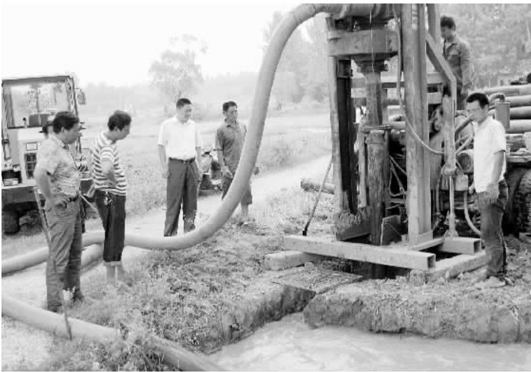
当下,正值“三夏”生产的关键时节。平桥区彭家湾乡陈寨村因村内的水库正在实施除险加固而无法蓄水,导致灌溉用水严重不足。市委选派干部、陈寨村党组织第一书记周烈显及时组织该村干部群众,多方筹资,打井抗旱。目前,该村已打机井3眼,秧苗移栽面积超过80%。图为周烈显(左三)在抗旱现场指导打井。
