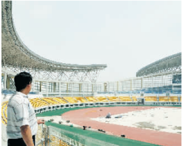
第七届全国农运会将于9月16日在河南省南阳市举行。南阳市本着隆重、热烈、节俭、简约的原则,精心组织,认真筹备,各项工作有序开展,场馆建设进展顺利,建设进度全面提升。图为5月30日拍摄的正在加紧建设中的农运会主场馆内景。
