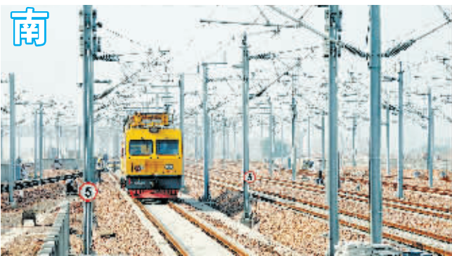
施工机械在京广客专郑州新东站工程工地施工。 新华社记者 朱祥 摄
