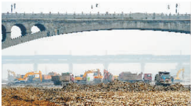
龙门大桥下伊河河道的施工场景。
