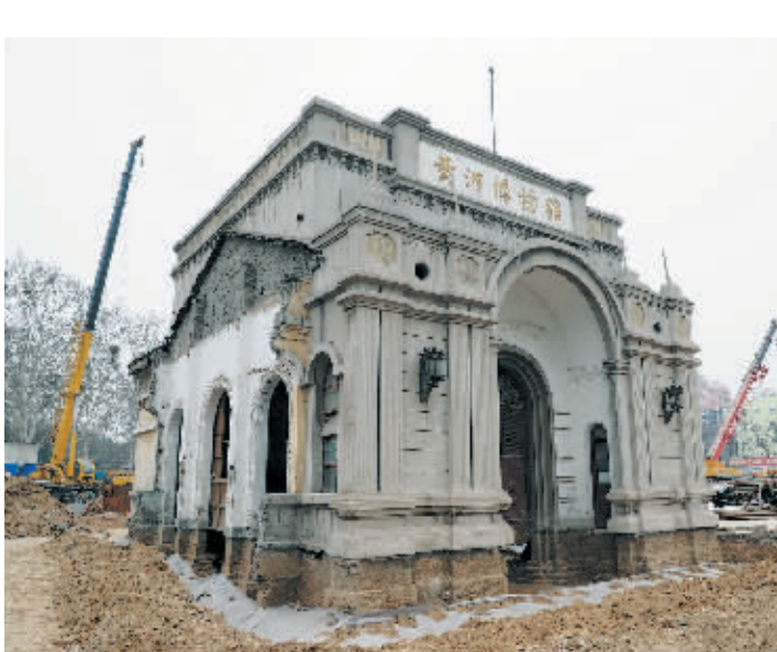
2月29日,黄河博物馆主楼地基已经清理结束。为配合郑州地铁建设,位于郑州市紫荆山的黄河博物馆将采取主楼平移、附属用房保护性拆除的方法进行拆迁。现在的黄河博物馆主楼向东平移100多米,附属建筑物予以拆除,待地铁施工完成后再恢复建筑原貌。黄河博物馆建于1955年,是世界上最早成立的江河博物馆之一。 新华社记者 赵鹏 摄
