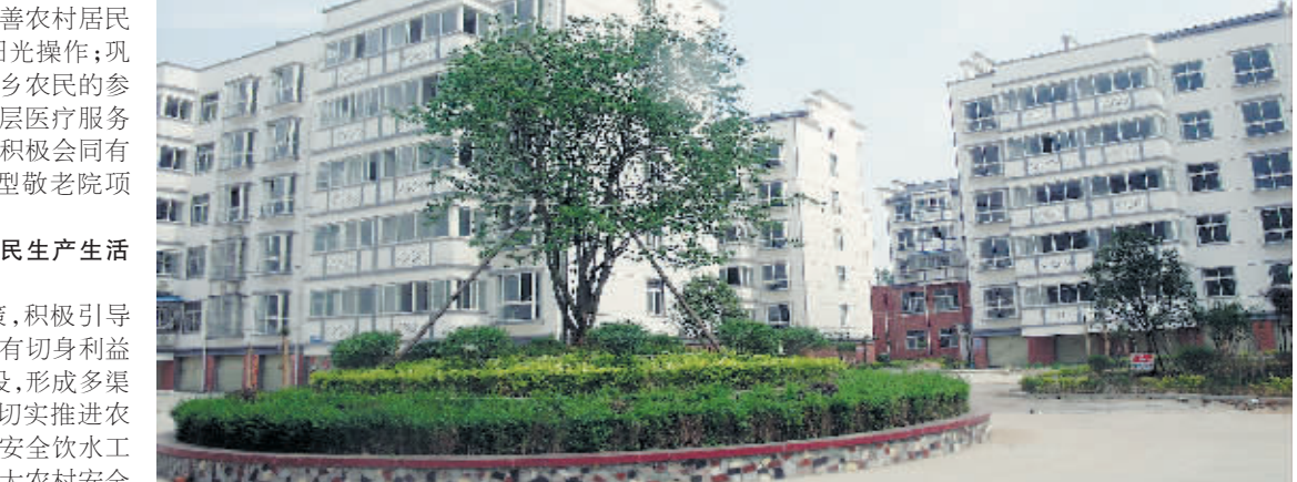
山店水库前期工程移民安置小区
