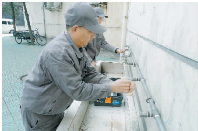
为增强广大学生的节水意识,减少对水资源的浪费,近日,信阳九牧洁具专卖店向我市部分学校捐赠了一批陶瓷芯水龙头,来更换校园内的老式螺旋铸铁水龙头。图为日前该店安装人员正在市三小更换水龙头。 本报记者 吴涛 摄
