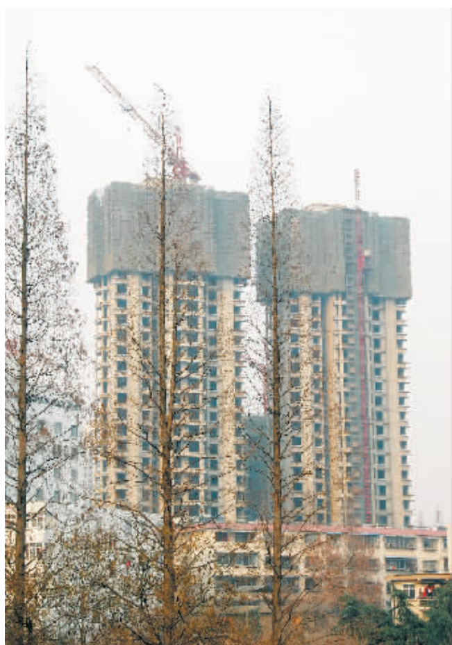
国家楼市调控政策持续发力,我市楼市应声降温,不少消费者正在等待观望中,期待进一步的利好消息。眼下,农历已进入七九,但耸立的塔楼和静静的吊塔传递的只是寂寞和冷清。 本报记者 刘正国 摄
