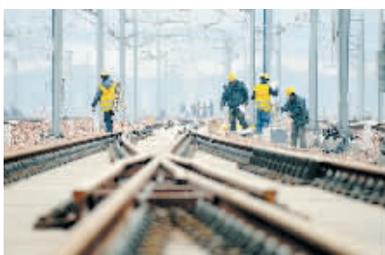
全球最大的综合性交通枢纽之一——高速铁路客运专线郑州新东站工程目前进展顺利。工程于2009年12月开工建设,计划于2012年年底全线建成通车。这是京广客运专线郑州新东站铁轨铺设施工现场。新华社记者 朱祥 摄
