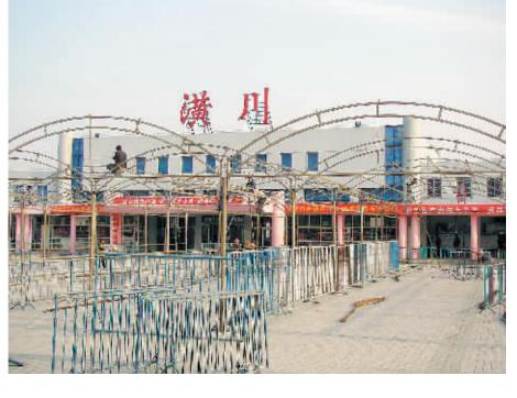
春运即将来临,作为京九 线河南境内最大的客运站潢 川火车站,为全面做好春运各 项准备工作,对站台地面进行 了防滑处理,更换了电子引导 系统和站台照明系统,并提 前搭建临时候车棚,安装实名 制验票口。图为该站工作人员 正在搭建临时候车棚。
